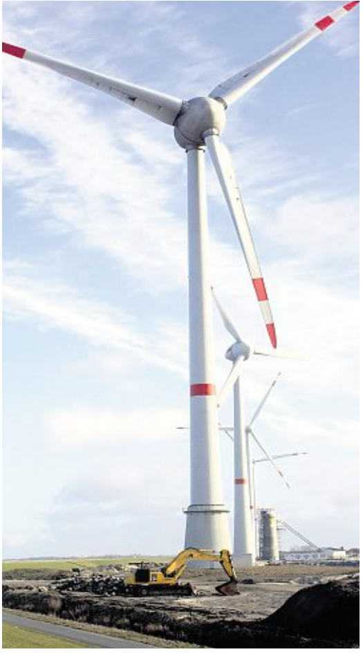
Die alten Testtrailer müht sich noch Platz zu machen: Bedenken, dass ein STRABAG-Terminal die Flugsicherheit beeinträchtigt, gibt es nicht. Foto: Koppe
